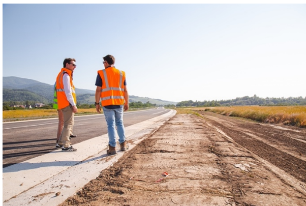
Photo prise durant le chantier du barreau
